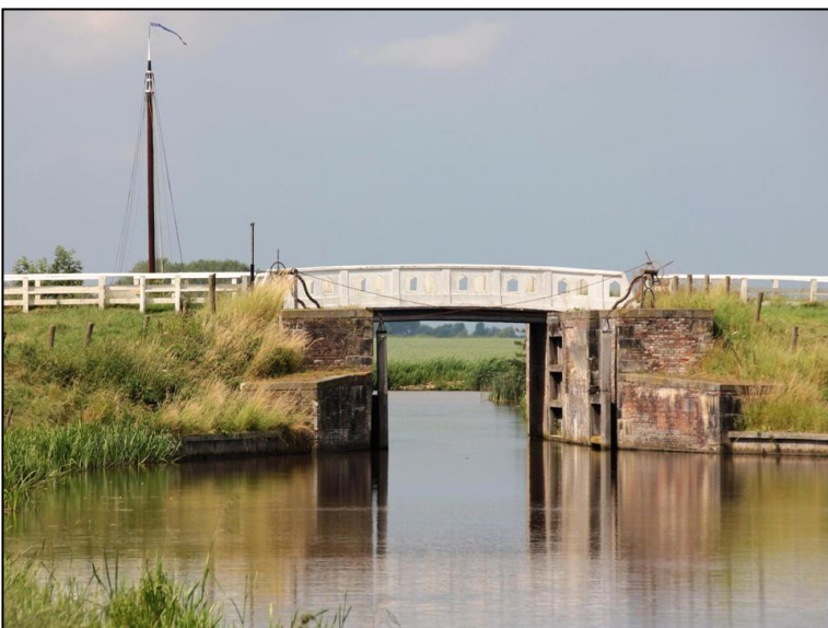
De Westerszijl of 'Oude Sluis' bij Aduarderszijl. Het Aduarderdiep komt tegenwoordig met twee mondingen in het Reitdiep uit. De westelijke – hier op de foto – dateert van 1706-1707, maar is niet de oudste van de twee. Hij ligt even ten oosten van de plek waar de oorspronkelijke monding van het Aduarderdiep wordt vermoed.
